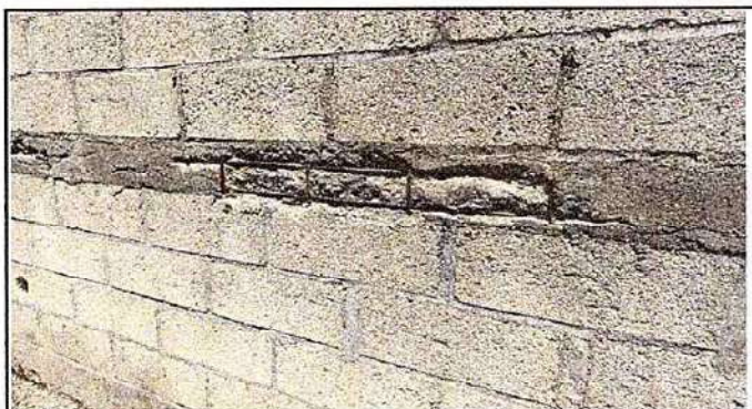
Foto9: 15 MUROS PERIMETRALES 15.1 Reparacion de muro perimetral de block
