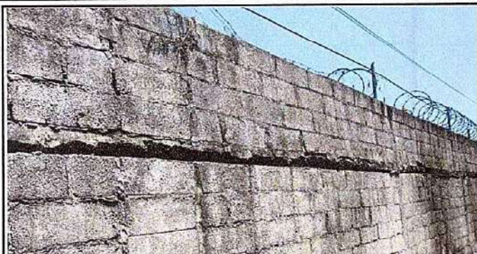
Foto7: 15 MUROS PERIMETRALES 15.1 Reparacion de muro perimetral de block
