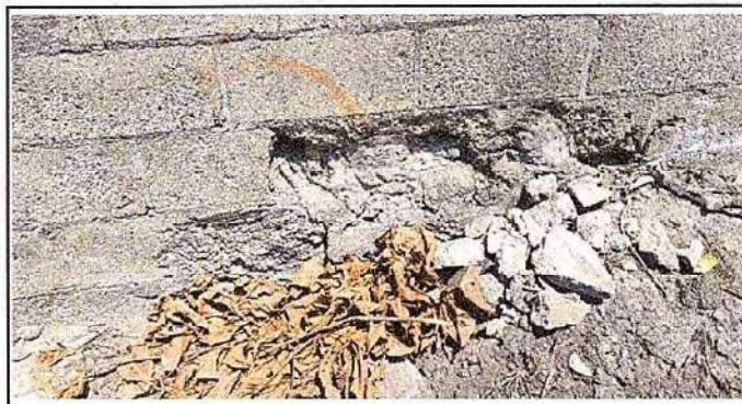
Foto10: 15 MUROS PERIMETRALES 15.1 Reparacion de muro perimetral de block
