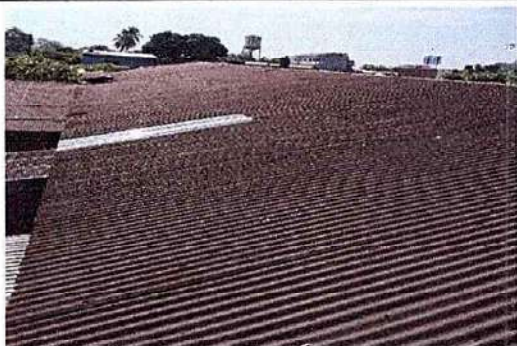
Foto1: 1. CUBIERTA DE LÁMINA 1.1 Sustitución de lámina, por lámina troquelada aluzinc calibre 26
