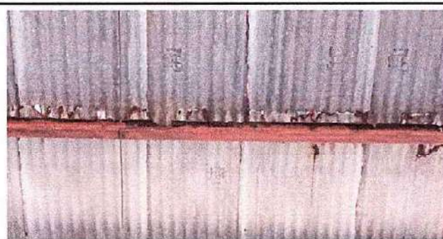
Foto 6: 2 ESTRUCTURA DE TECHO 2.3 Sustitución de estructura de soporte de metal, por metal
