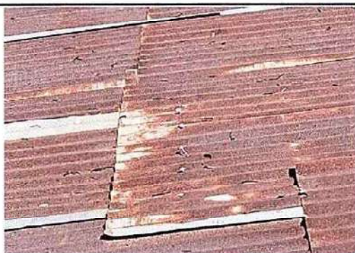
Foto 3: 1 CUBIERTA DE LÁMINA 1.3 Sustitución de elementos de fijación
