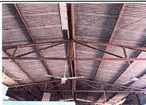
Foto 4: 2 ESTRUCTURA DE TECHO 2.1 Mantenimiento a estructura de soporte de metal
