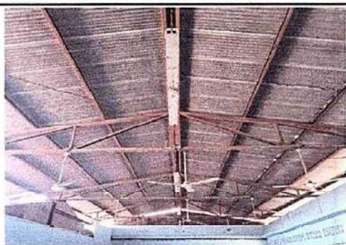
Foto 5: 2 ESTRUCTURA DE TECHO 2.1 Mantenimiento a estructura de soporte de metal
