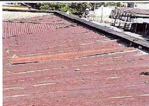
Foto 2: 1 CUBIERTA DE LÁMINA 1.2 Sustitución de capote de lámina troquelada
