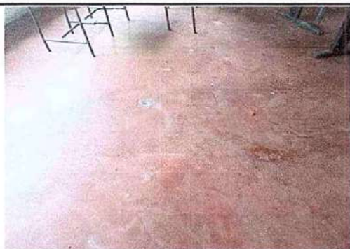
Foto 5: 6 PISO 6.11 Sustitución de piso de cemento, por piso cerámico.
