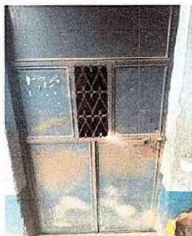
Foto 1: 4 PUERTAS DE METAL 4.1 Mantenimiento a estructura (lijado, cambio de tubo, cepillado, sujeciones, aplicación de pintura)
