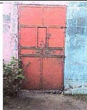
Foto 2: 4 PUERTAS DE METAL 4.3 Sustitución de puerta de Metal
