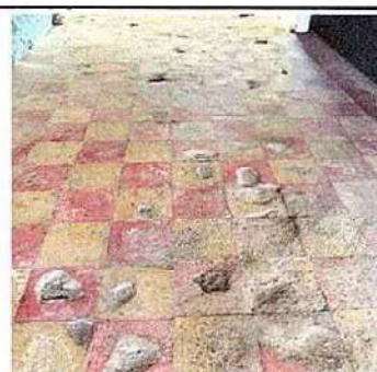
Foto 6: 6 PISO 6.11 Sustitución de piso de cemento, por piso cerámico
