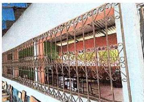
Foto 3: 5 VENTANAS 5.7 Mantenimiento a balcones de metal
