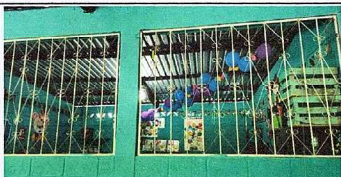
Foto 3: 5. VENTANAS 5.7 mantenimiento balcones de metal
