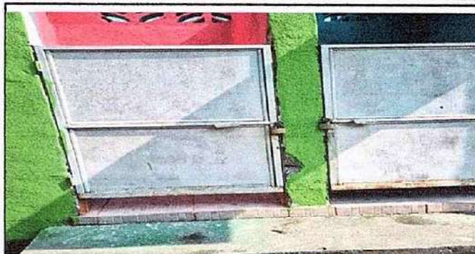
Foto 2: 4.PUERTA DE METAL 4.1 mantenimiento a estructura (lijado, cambio de tuvo, cepillado cepillado, sujeciones, aplicación de pintura)
