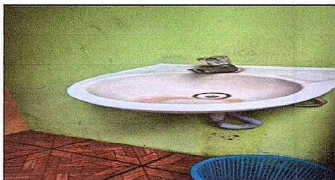
foto 9: 10 SERVICIOS SANITARIOS Y SUS ACCESORIOS. 10.5 Sustitución de lavamanos
