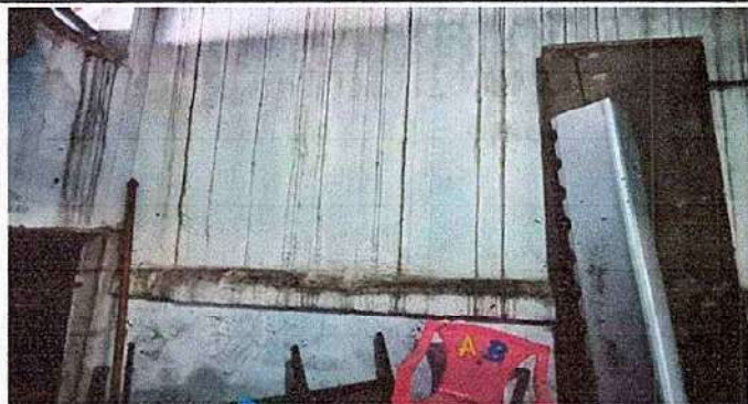
Foto 7: 9 PINTURA DE MUROS EXTERIORES E INTERIORES. 9.1 pintura en muros exteriores e interiores.
