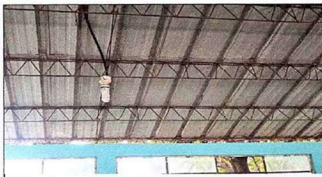
Foto 3: 1 CUBIERTA DE LAMINA. 1.3 Sustitución de elementos de fijación.
