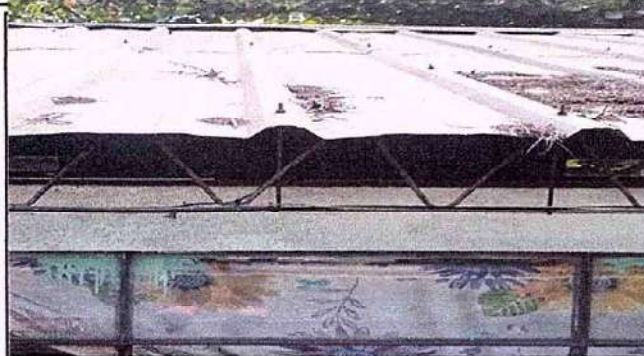
Foto 2: 1 CUBIERTA DE LAMINA. 1.2 Sustitución de capote de lámina por lámina troquelada.
