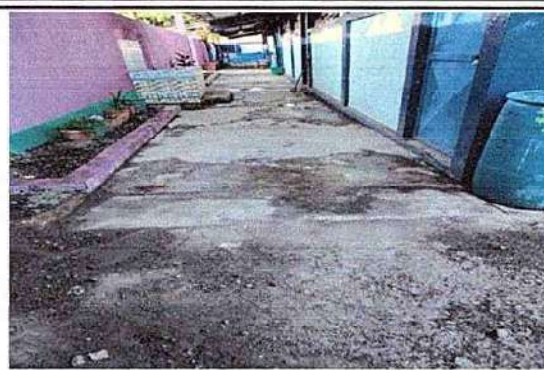
Foto 2: 6. PISO 6.10 Sustitución de piso de concreto por piso cerámico
