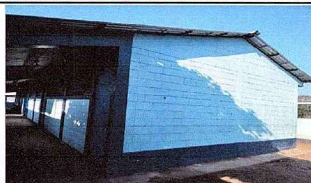
Foto 4: 9. PINTURA EN MUROS EXTERIORES E INTERIORES 9.1 Pintura en muros exteriores e interiores
