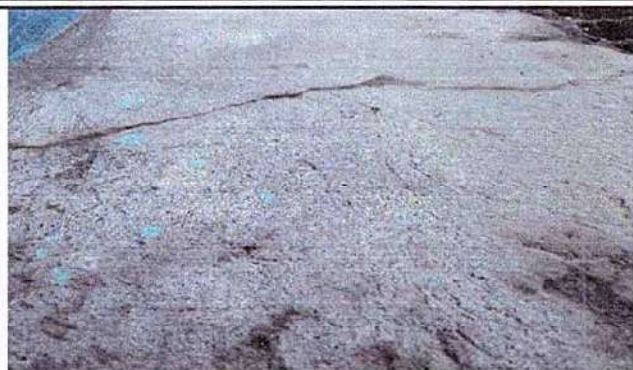
Foto 1: 6. PISO 6.5 Sustitución de piso de torta de concreto.
