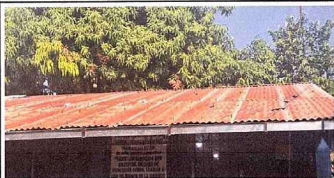
Foto1: 1. CUBIERTA DE LAMINAS. 1.1 Sustitucion de lamina, por lamina troquelada aluzinc calibre 26 1.2 Sustitucion de capote para lamina troquelada
