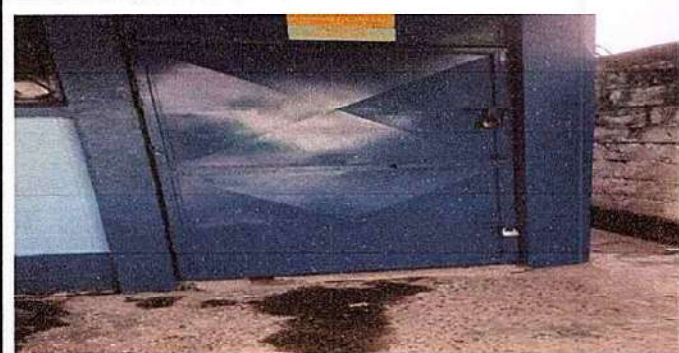
Foto 3 4 PUERTA DE METAL 4.2 Sustitucion de chapa
