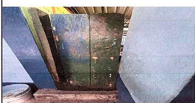
Foto. 4 4 PUERTA DE METAL 4.3 sustitucion de puerta
