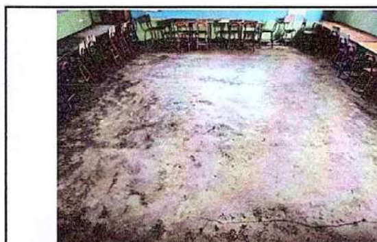
Foto 6: 6. PISO 6.10 Sustitución de piso de cemento, por piso cerámico
