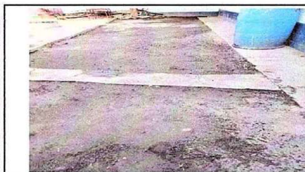
Foto 5: 6. PISO 6.5 Sustitución de piso de torta de concreto
