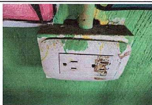
Foto 10: 17. REPARACIÓN DE SISTEMA ELÉCTRICO 17.11 Reparación de cableado eléctrico. Instalación de acometida eléctrica: reparación de cableado eléctrico, instalación eléctrica desde caja principal para aula incluye desinstalación de tomacorriente y apagadores plafoneros existentes y reinstalación de las
