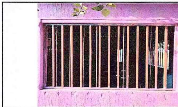
Foto 4: 5. VENTANAS 5.7 Mantenimiento a balcones de metal
