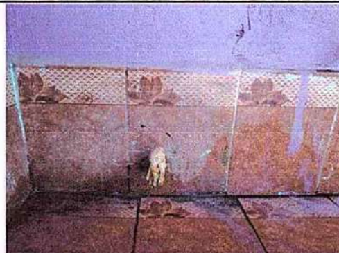
Foto 8: 10. SERVICIOS SANITARIOS Y SUS ACCESORIOS 10.5 Sustitución lavamanos
