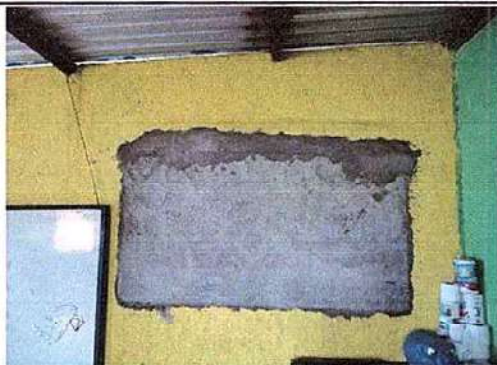
Foto 7: 9. PINTURA EN MUROS EXTERIORES E INTERIORES 9.1 Pintura en muros exteriores e interiores
