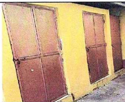
Foto 3: 10. SERVICIOS SANITARIOS Y SUS ACCESORIOS. 10.1 Mantenimiento a estructura (lijado, cambio de tubo, cebillado, sugerencias, aplicación de pintura a puerta de servicios sanitario)
