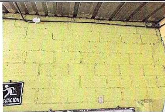
Foto 2: 9. PINTURA 9.1 Pintura en muros exteriores e interiores.
