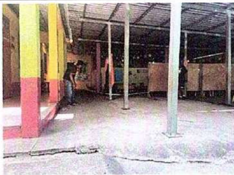
Foto1: 6 PISO 6.10 Sustitución de piso de concreto, por piso cerámico
