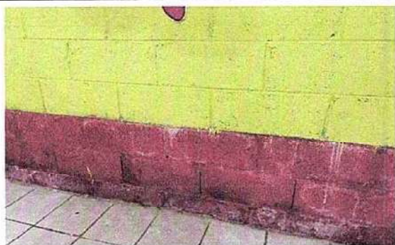
Foto 2: 9. PINTURA 9.1 Pintura en muros exteriores e interiores.
