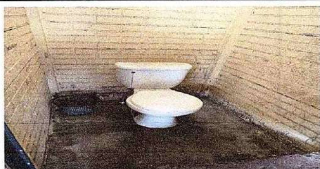
Foto 3: 10.2 Sustitución de accesorios inodoro (contra Llave, tubo de abasto y tanque
