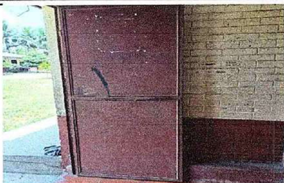
Foto 1: 4.1 Mantenimiento a estructura (Lijado, cambio de tubo, cepillado, sijecciones, aplicación de pintura)
