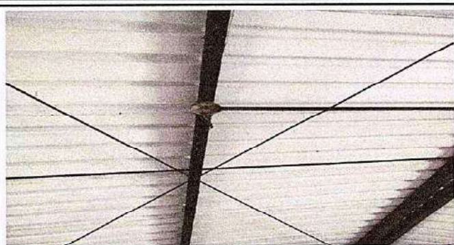
Foto 8: 17.5 Sustitución de plafoneras
