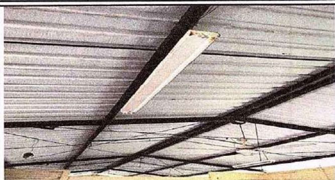
Foto 7: 17.4 Sustitución de focos ahorradores
