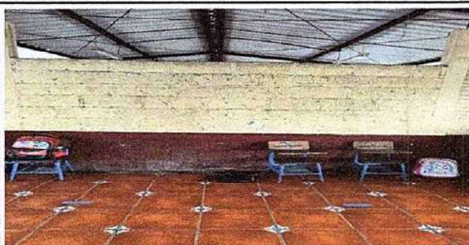
Foto 15: 21.1 Repello en muro
