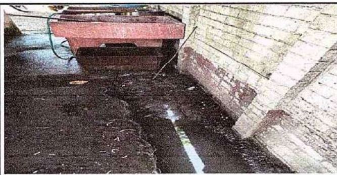
Foto 6: 14.8 Sustitución de caja de registro
