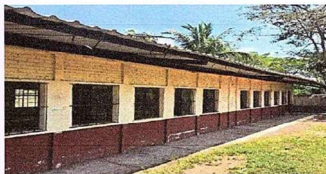
Foto 2: 5.6 Sustitución de balcones de metal
