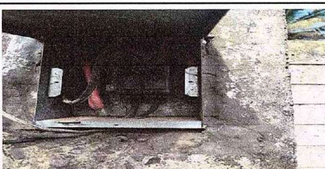
Foto 12: 17.9 Sustitución de flipones
