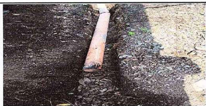
Foto 5: 14.3 Sustitución de tubería de PVC línea principal aguas negras
