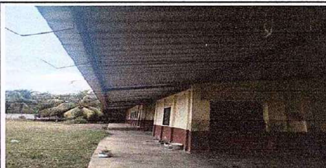
Foto 14: 17.11 Sustitución de ducto electrico + accesorios
