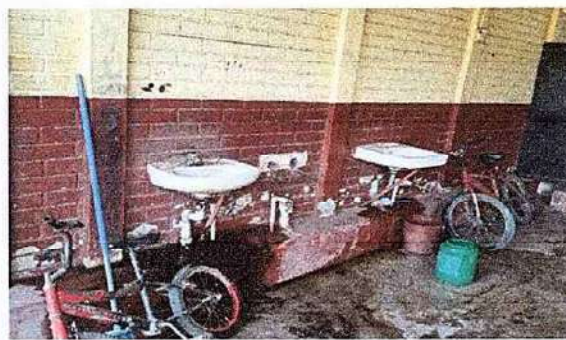
Foto 4: 10.5 Sustitución de Lavamanos.
