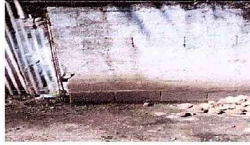
Foto 2: 15.1 Reparación de muro perimetral de block.
