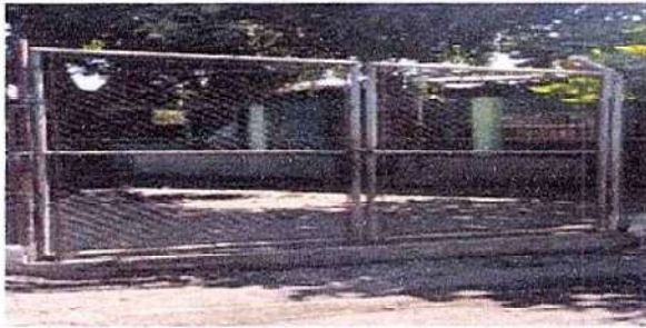
Foto 1: 4.1 Sustitución de portón de metal
