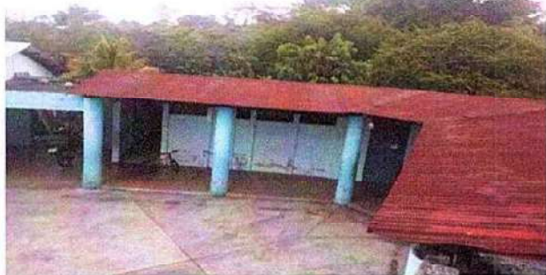
Foto 1: 1.1 Sustrucción de Lamina
