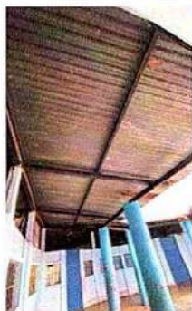
Foto 3: 2.1 Mantenimiento a estructura de soporte de metal
