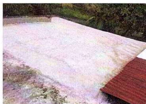
Foto 4: 3.1 Impermeabilización de losa
