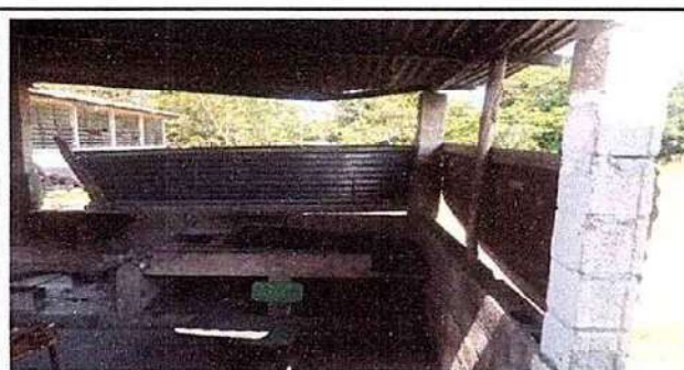
15.1 Reparacion de muro perimetral de block por lamina deteriorada para cubrir del viento
