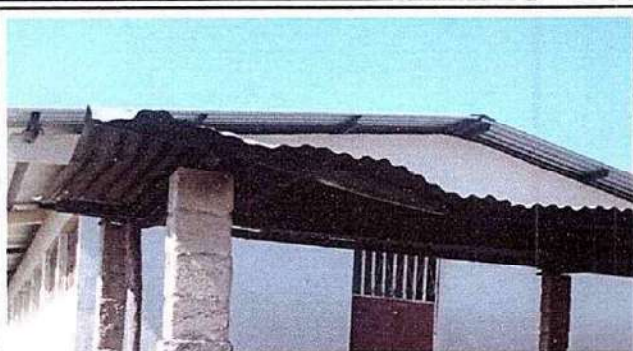
1.1 Sustitución de Lamina por lamina troquelada aluzinc calibre 26 1.2 Sustitucion de elementos de fijacion
