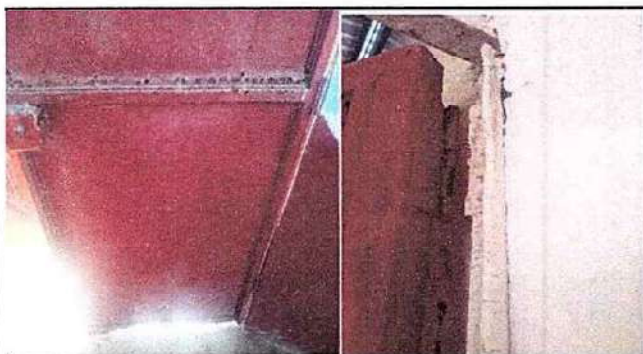
4.1 mantenimiento de estructura y aplicacion de pintura
