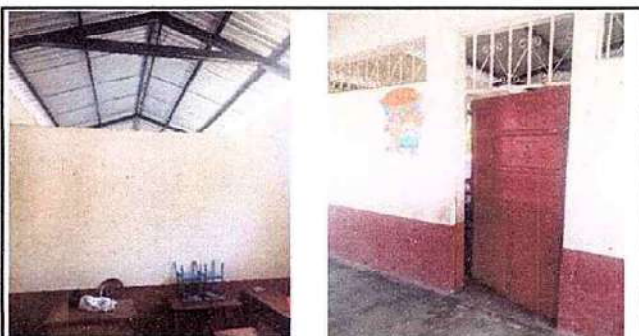
9.1 pintura de muros interiores y exteriores
