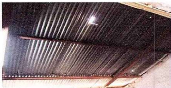
Foto1: 1.1 Sustitución de Lamina por lamina troquelada aluzinc calibre 26
