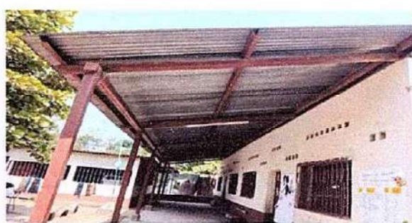
Foto 2: 2.1 Mantenimiento a estructura de soporte de metal
