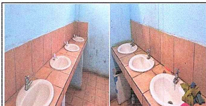
Foto 5: Sustitución de mezcladora de lavamanos
