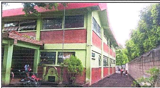
Foto 2: Pintura en muros interiores y exteriores
