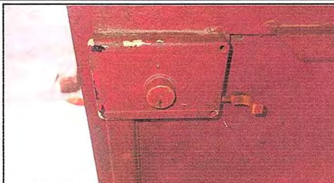
Foto 2: Sustitucion de chapa
