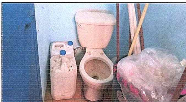
Foto 4: sustitución de tapaderas de sanitario
