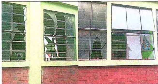
Foto 6: Sustitución de vidrios
