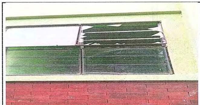
Foto 5: Sustitucion de estructura de metal de ventana
