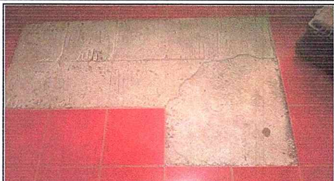
Foto 1: Sustitución de piso cerámico
