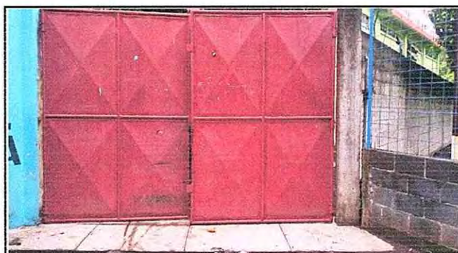
Foto 4: Sustitucion de portón de metal
