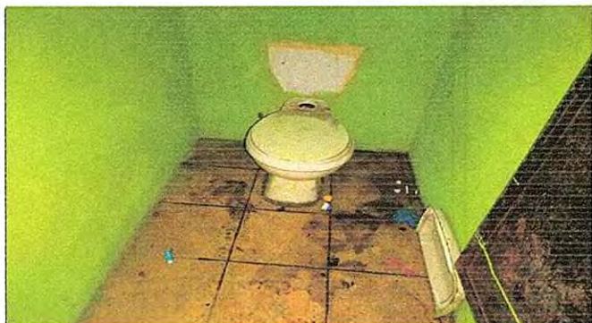
Foto 3: Sustitucion de puerta en servicio sanitario
