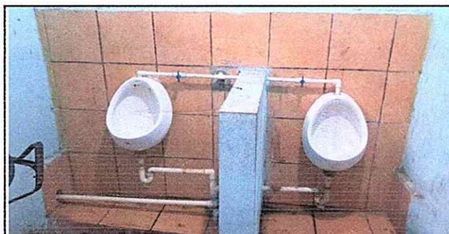
Foto 6: Sustitución de llave en migitorio
