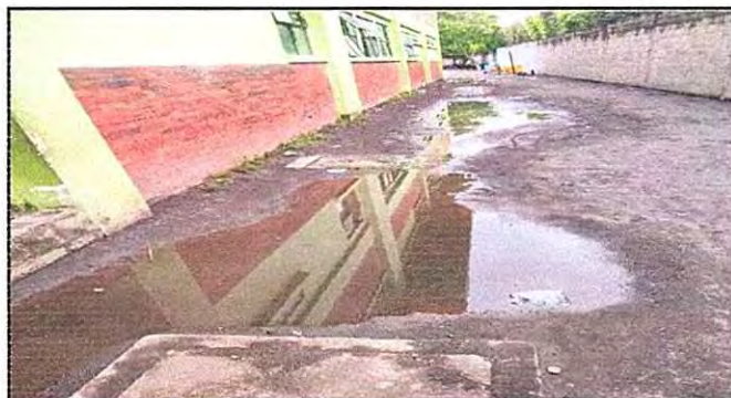
Foto 4: sustitución de caja de registro
