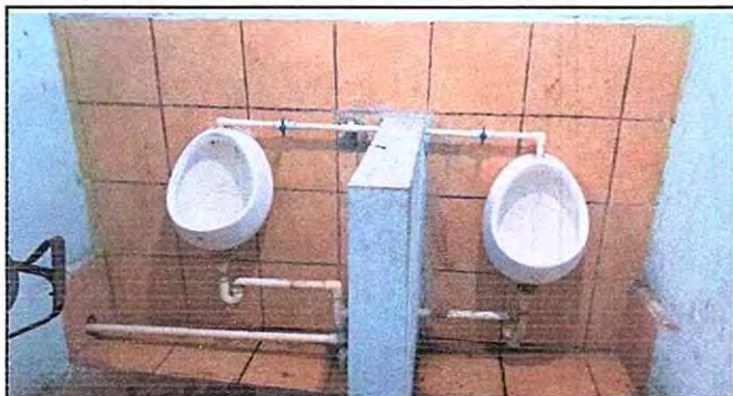
Foto1: Sustitución de migitorio
