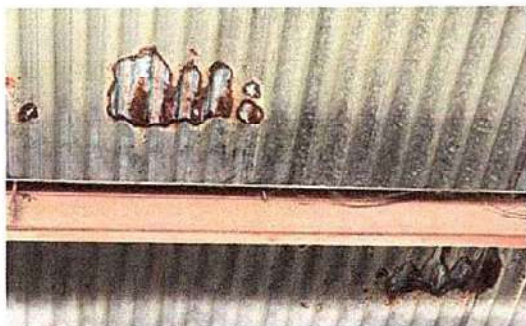
Foto 1: 1.1 Sustitución de Lamina por lamina troquelada aluzinc calibre 26
