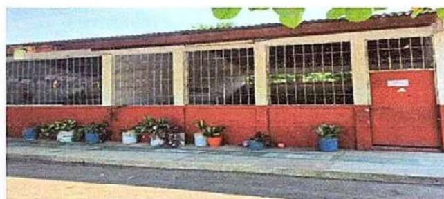
Foto 6: 9.1 Pintura en muros exteriores e interiores
