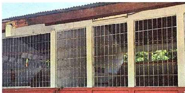
Foto 5: 5.1 Mantenimiento a balcones de metal
