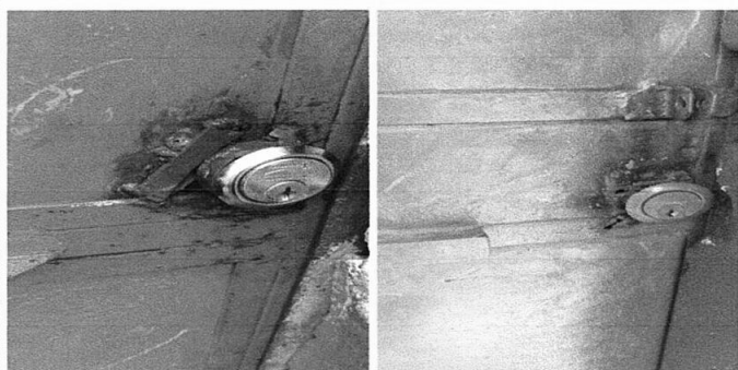
Foto 3: 4.2 Sustitución de chapa
