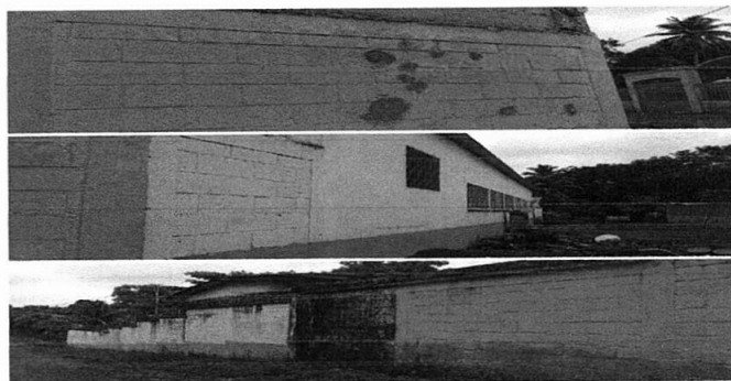
Foto 10: 9 Pintura en muros exteriores e interiores. 9.1 Pintura en muros exteriores e interiores
