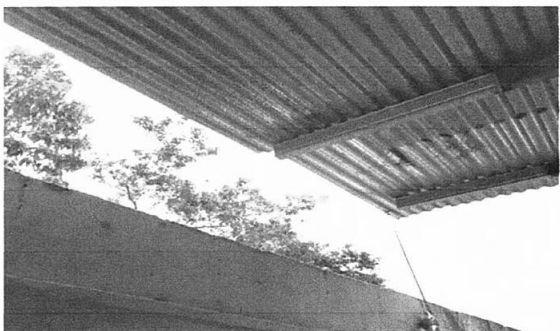
Foto 1: 2 ESTRUCTURA DE TECHO: 2.3 Sustitucion de estructura de soporte de metal, por metal
