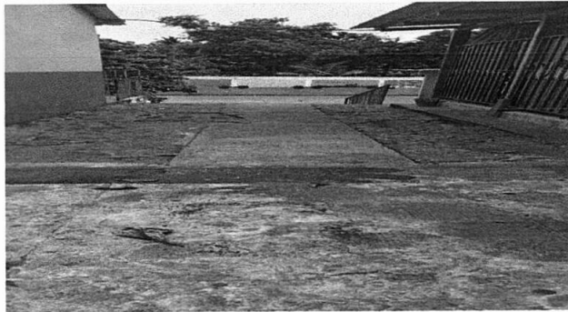
Foto 14: 16 Losa de patio/16.1 Reparación de planchas de concreto de patio
