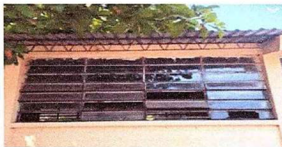
Foto 2: 5.2 Sustitución de estructura de metal de ventana (balcon)
