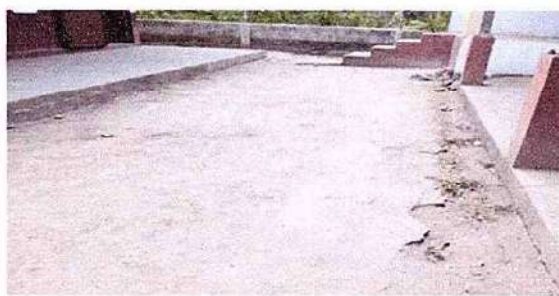
Foto 6: 16.1 Reparación de plancha de concreto de patio
