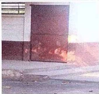
Foto 1: 4.1 Mantenimiento a estructura (Lijado, cambio de tubo, cepillado, lijeciones, aplicación de pintura)
