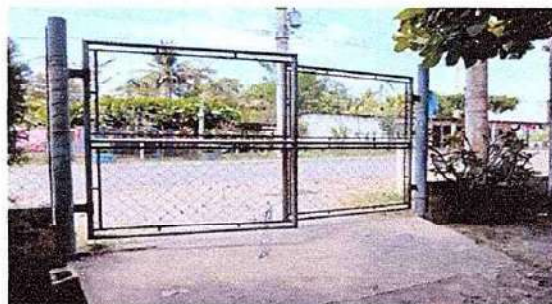
Foto 4: 12.1 Mantenimiento de Porton
