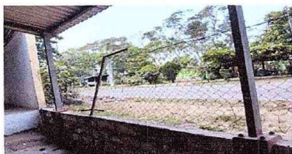
Foto 5: 15.2 Reparación de muro perimetral de block con tubo hg y malla galvanizada, soleras intermedias y columnas.
