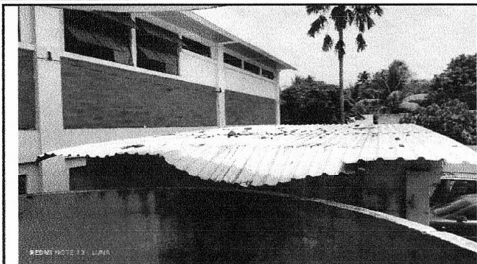
REGLÓN 1: CUBIERTA DE LÁMINA
