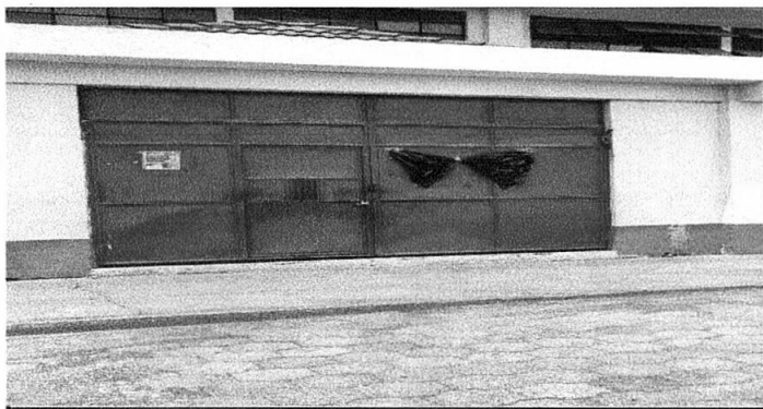
REGLON 12. Mantenimiento de portones
