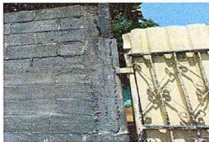
Foto 2: RENGLO 4.5 SUSTITUCION DE PORTON DE METAL
