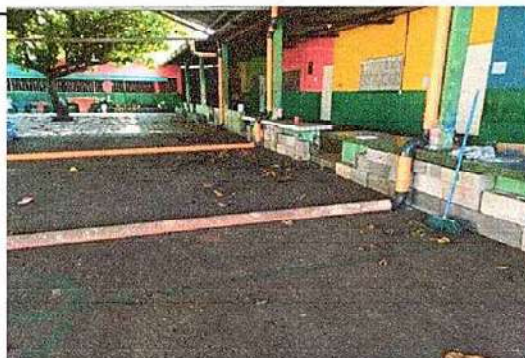
Foto 4: RENGLO 7.3 REPARACION DE BAJADA DE AGUA PLUVIAL TUBO PVC 3"
