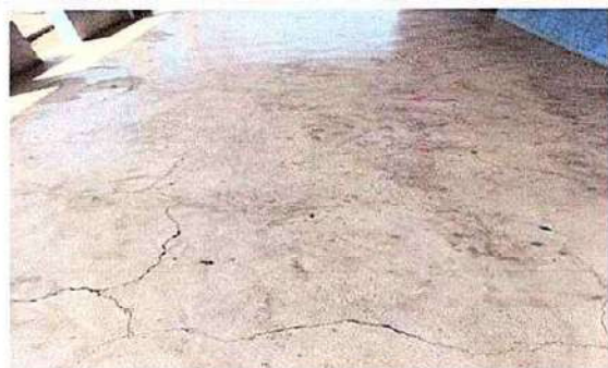
Foto 3: 6.10 Sustitución de piso de concreto por piso cerámico, 2 salones y corredor.
