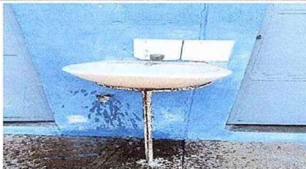
Foto 6: 10.5 Sustitución de lavamanos.
