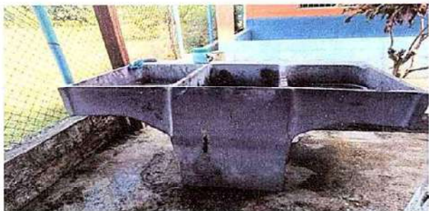
Foto 7: 20.1 Sustitución de pila de cemento de dos lavaderos.
