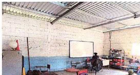
Foto 8: 21.1 Repello en muro
