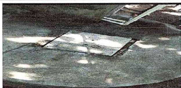
Foto 9: SUSTITUCION DE BOMBA DE AGUA
