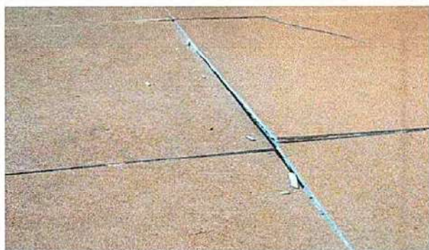
Foto 3: REPARACION DE PISO CERAMICO
