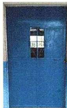
Foto 2: MANTENIMIENTO A ESTRUCTURA (LIJADO, CAMBIO DE TUBO, CEPILLADO, SUJECIONES, APLICACIÓN DE PINTURA)
