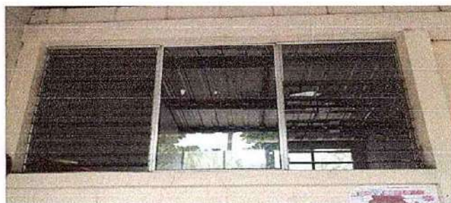
Foto 10: FABRICACION E INSTALACIÓN DE BALCON DE METAL
