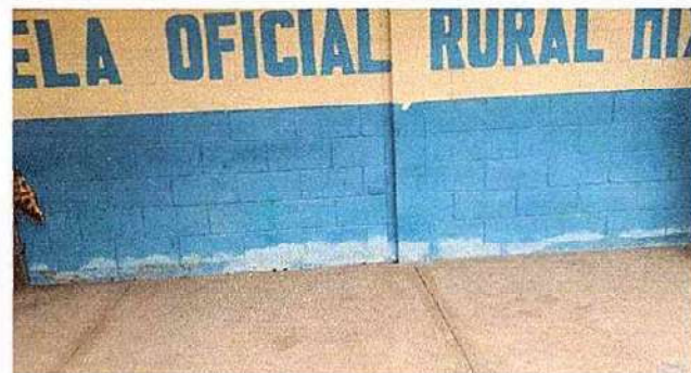
Foto 4: PINTURA DE MURO EXTERIORES E INTERIORES
