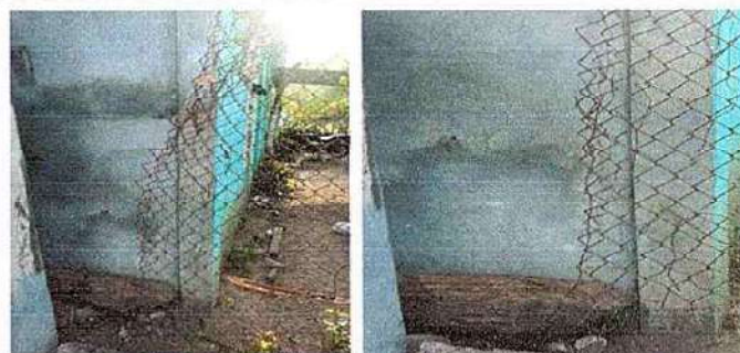
Foto 8: REPARACION DE MURO PERIMETRAL MALLA
