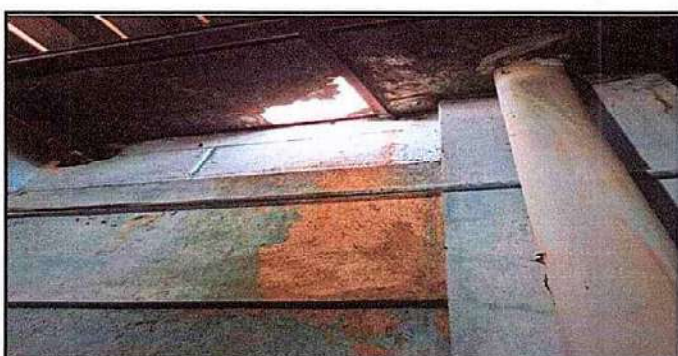
Foto 5: 7.1 Sustitución de canal de metal
