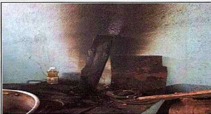
Foto 7: 20.6 Sustitución de chimenea de metal
