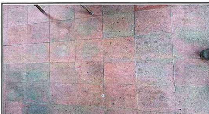
Foto 3: 6.7 Sustitución de piso de granito por piso cerámico
