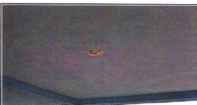
Foto 6: 19.11 Instalación unidades luz ( Incluye interruptor, ducto y cable eléctrico)
