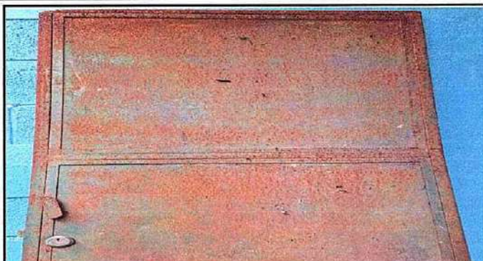
Foto 1: 4.3 Sustitución de puerta
