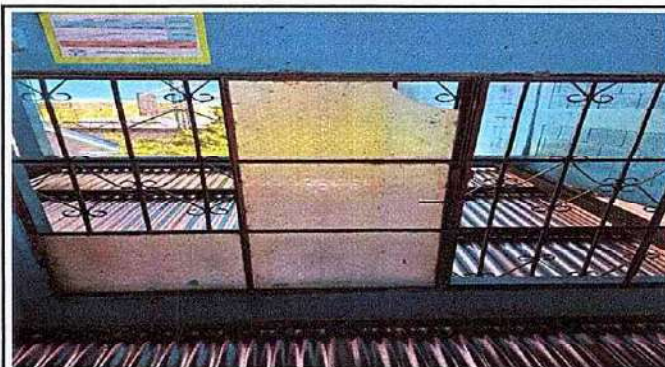
Foto 2: 5.2 Sustitución de estructura de metal de ventana por PVC
