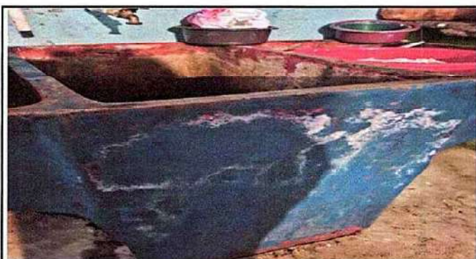
Foto 9: 20.8 Sustitución de pila de dos lavaderos
