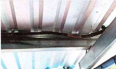
Foto 7: REPARACIÓN DE SISTEMA ELÉCTRICO 17.11 Reparación de cableado eléctrico
