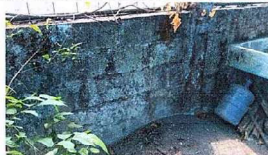
Foto 10: REPARACIÓN DE REPELLO Y CERNIDO DE PAREDES (CUANDO APLIQUE) 21.2 Cernido en muro
