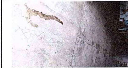
Foto 1: PISO 6.8 Sustitución de piso de cemento líquido
