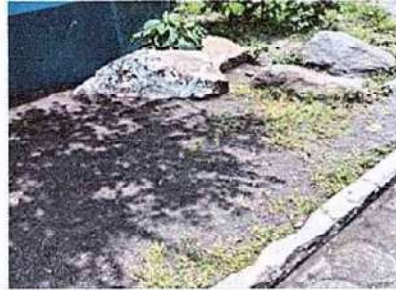
Foto 2: CUNETAS DE CONCRETO 8. 2 Reparación de banquetas de concreto
