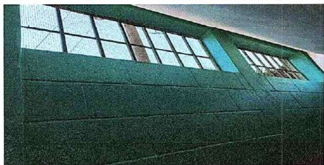
Foto 3: 5.2 Sustitución de estructura de metal de ventana (por ventanas de pvc)
