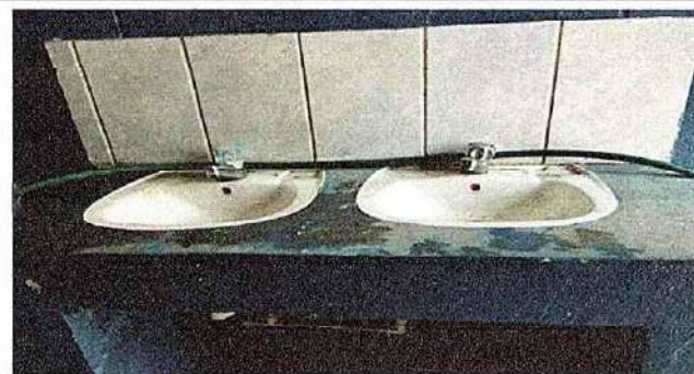
Foto 6: 10.5 Sustitución de lavamanos.
