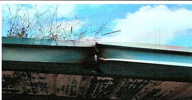
Foto 3: 7.1 Sustitución de canal de metal existente dañado, por canal de metal nuevo
