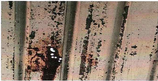
Foto1: 1.1 Se estara cambiando la lamina existente dañada por lamina nueva, lamina troquelada Aluzinc calibre 26
