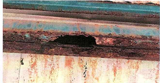
Foto 2: 2.3 Sustitución de costanera existente dañada, por costanera nueva GHT
