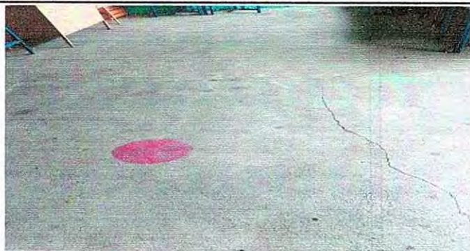
Foto 1: 6.10 Sustitución de piso de concreto por piso cerámico, para 3 aulas
