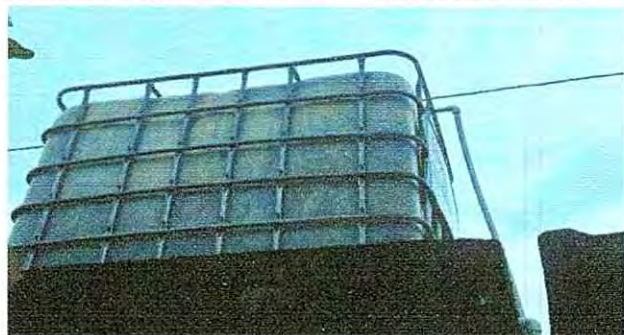
Foto7: 18.3 Sustitución de deposito de agua 1700 lt
