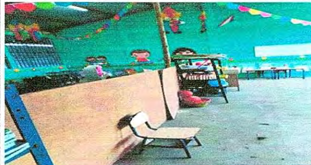
Foto 10: 24.1 Sustitución a tablayeso, division de aulas
