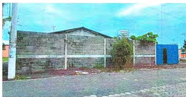
Foto 9: 21.1 Repello en muro
