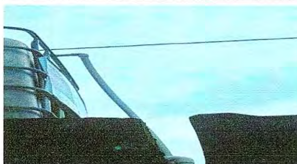
Foto 8: 18.5 Sustitución de accesorios depositos de agua
