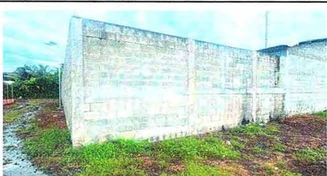
Foto 3: 9.1 Pintura en muro exteriores e interiores
