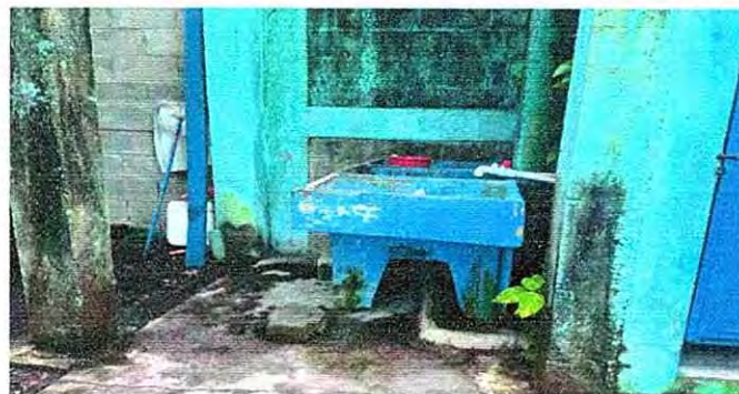
Foto 2: 8.2 Reparación de banqueta de concreto
