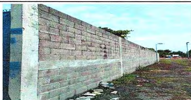
Foto 6: 15.1 Reparación de muro perimetral de block
