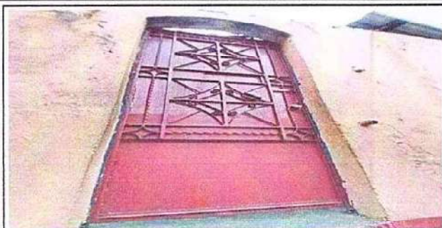
Foto1: 4.3 Sustitución de puerta.
