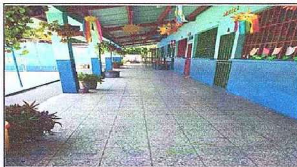
Foto 4: 6.7 Sustitución de piso granito.
