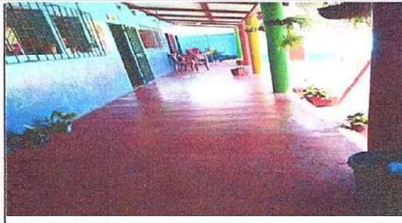
Foto 2: 6.5 Sustitución de piso torta de concreto.
