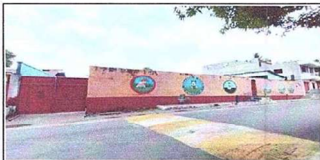
Foto 5: 9.1 Pintura en muros exteriores e interiores.
