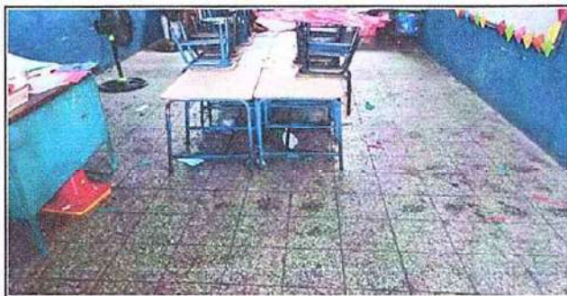
Foto 3: 6.7 Sustitución de piso granito.
