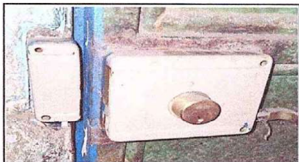
Foto 4: 4.2 aplicación de pinturaSustitucion de chapa.
