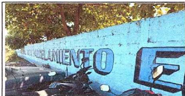
Foto 5: 9.1 Pintura en muros exteriores e interiores
