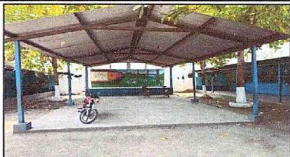
Foto 2: 1.1 Sustitución de laminas, 2.3 sustitución de soporte de metal por metal, 1.3 Sustitución de elementos de fijacion
