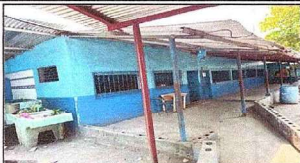
Foto1: 1.1 Sustitución de laminas, 2.3 sustitución de soporte de metal por metal, 1.3 Sustitución de elementos de fijacion
