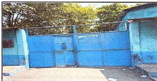
Foto 6: 12.1 mantenimiento a porton de metal
