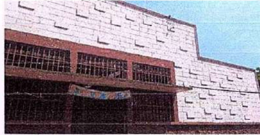
Foto 8: 9.1 Pintura en muros exteriores e interiores
