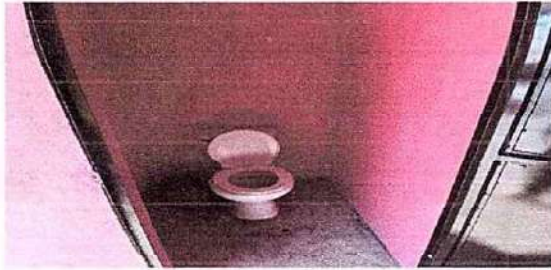
Foto7: 6.8 Sustitución de piso cerámico
