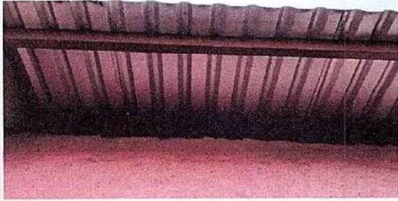
Foto 1: 1.1 Sustitución de lámina, por lamina troquelada aluzinc calibre 26
