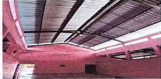
Foto 2: 2.1 Mantenimiento de estructura de soporte de metal
