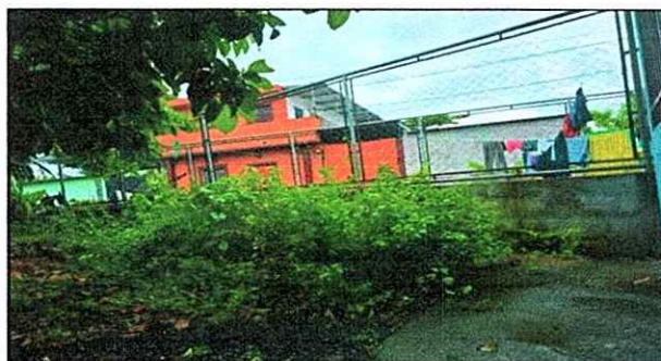
Foto 4: 15.6 Sustitucion de muro perimetral de tubo hg y malla galvanizada por muro perimetral de block
