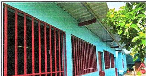
Foto 5: 19.7 Instalación de Estructura Portante de metal. 19.8 Instalación de Lámina Troquelada Aluzinc. 19.9 Desinstalación de Estructura Portante. 19.10 Desinstalación de Lámina Existente.
