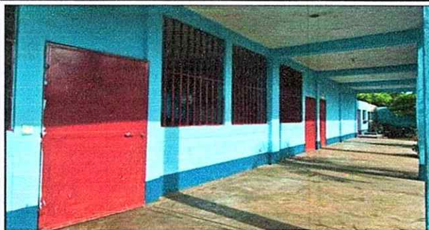
Foto1: 4.1 Mantenimiento a Estructura lijado, cambio de tubo, cepillado, sujeciones, aplicación de pintura)
