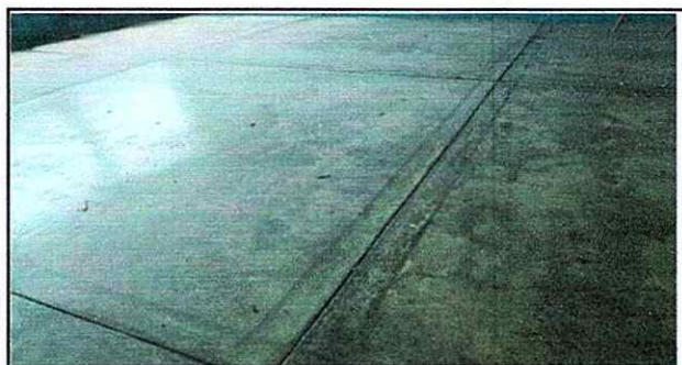
Foto 3: 6.10 Sustitución de piso de concreto por piso cerámico
