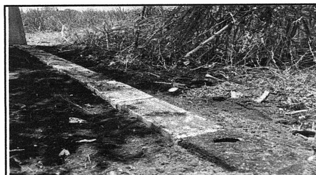
Foto 4: 15.6 Mejoramiento a muro perimetral con 3 hiladas de block mas malla y tubo galvanizado
