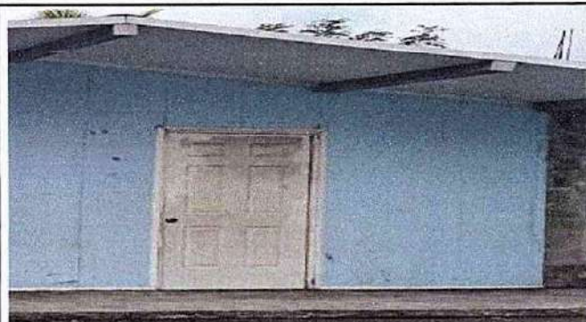
Foto 2: 4.3. Sustitución de puerta de metal
