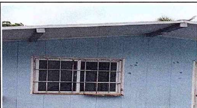
Foto 4: 5.6. Sustitución de balcones de metal
