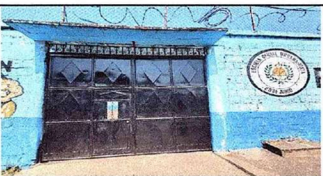
Foto 11: 12.1 Mantenimiento a Portones de metal
