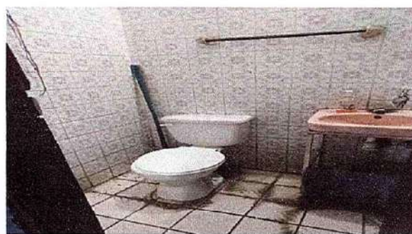
Foto 12: 13.1 Sustitución de azulejos.
