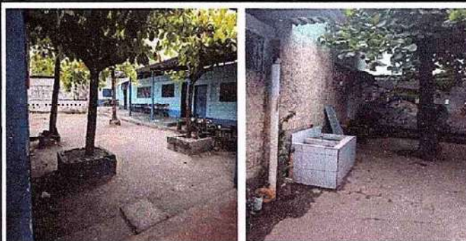
Foto 8: 8.2 Reparación de banqueteta de concreto
