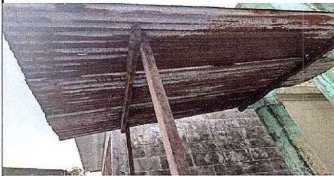
Foto1: 1.1 Sustitución de lámina, por lámina troquelada aluzinc calibre 26. 2.2 Sustitución de estructura de soporte de madera por metal
