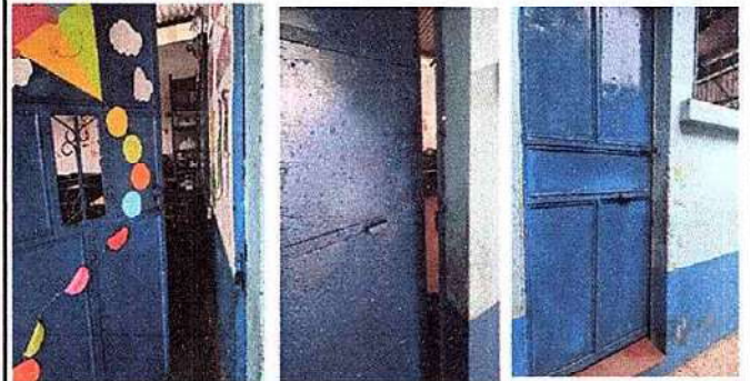
Foto 2: 4.1 Mantenimiento a estructura (lijado, cambio de tubo, cepillado, sujeciones) 4.2 Sustitución de Chapa.
