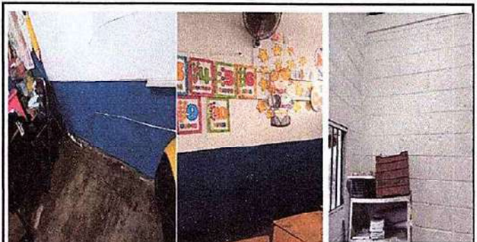
Foto 16: 17.6 Sustitución de tomacorrientes dobles
