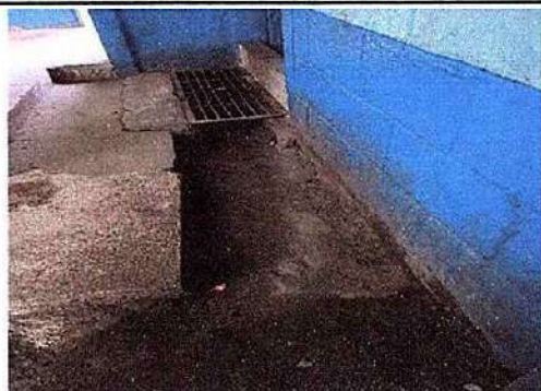
Foto 7: 8.1 Reparación de cuneta de concreto
