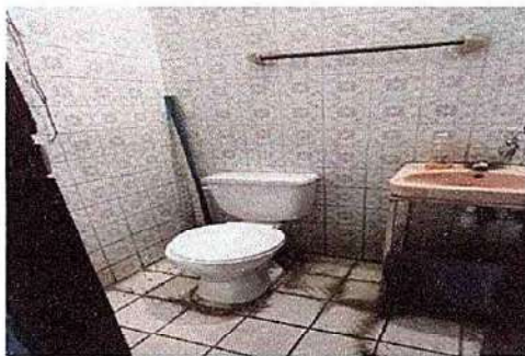
Foto 5: 6.0 Sustitución de piso cerámico
