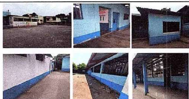
Foto 9: 9.1 Pintura en muros exteriores e interiores.
