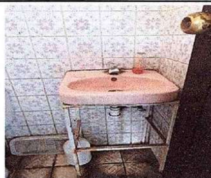
Foto 10: 10.5 Sustitución de lavamanos.
