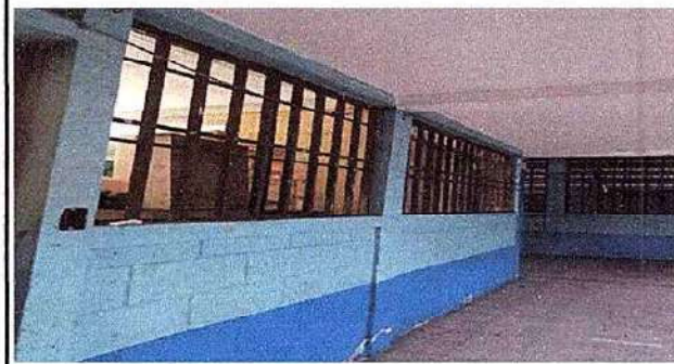
Foto 3: 5.5 Sustitución de estructura de metal de ventana.
