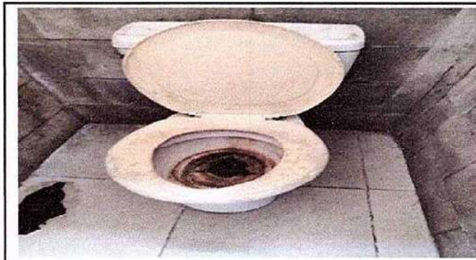
Foto 4: 10.3. Sustitución de inodoro
