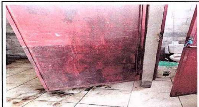
Foto 3: 10.1. Mantenimiento a estructuras (lijado, cambio de tubo, cepillado, sujeciones, aplicación de pintura) a puertos de servicios sanitarios.
