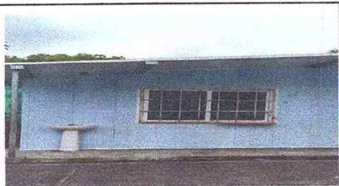
Foto1: 10.5. Sustitución de lavamanos Se trasladará a un lugar cerca de los baños exclusivo para docentes.
