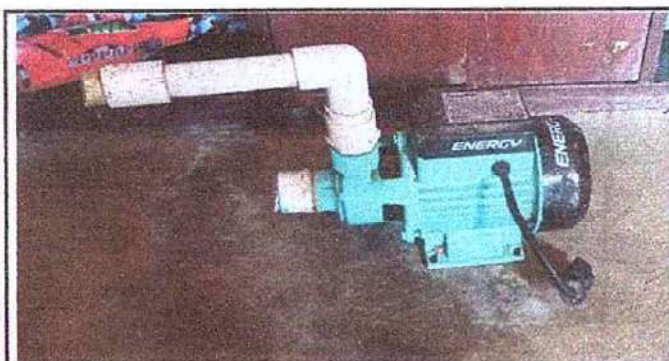
Foto 5: 16.5 Sustitución de bomba de agua
