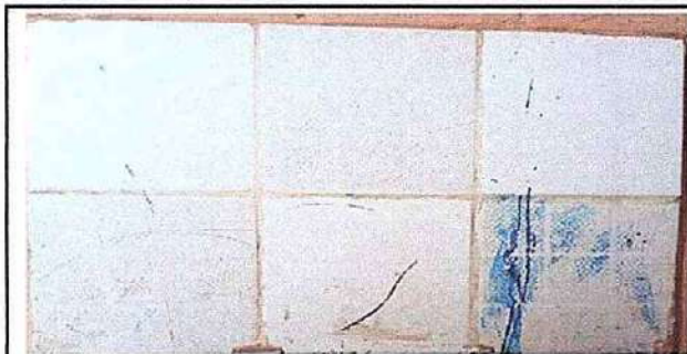
Foto 13: 13.1. Sustitución de azulejo
