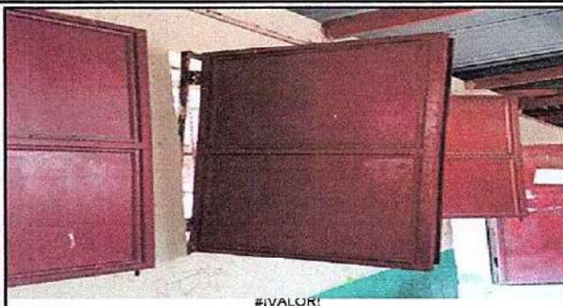
Foto 2: 5.1 Mantenimiento a estructura de metal de ventana
