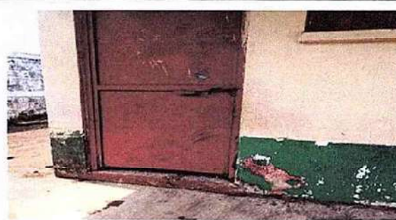
Foto 8: 10.1 Mantenimiento a estructura(lijado, cambio de tubo, cepillado, Sujeciones, Aplicación de Pintura) a Puertas servicios sanitario
