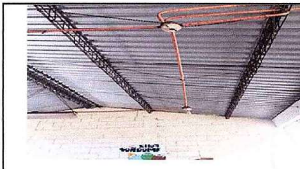
FOTO 15. 17.4 Sustitución de focos ahorradores. 17.5 Sustitución de plafoneras
