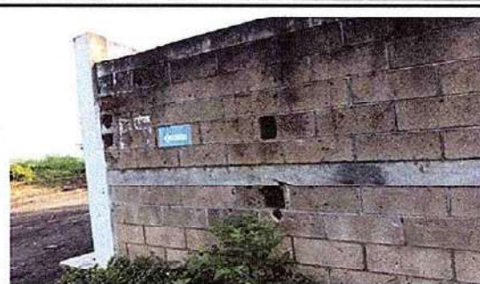
Foto 14: 15.1 Reparación de Muro perimetral de block
