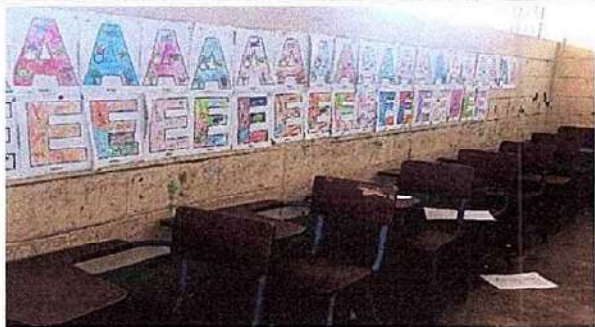
Foto 7: 9.1 Pintura de muros exteriores e interiores .
