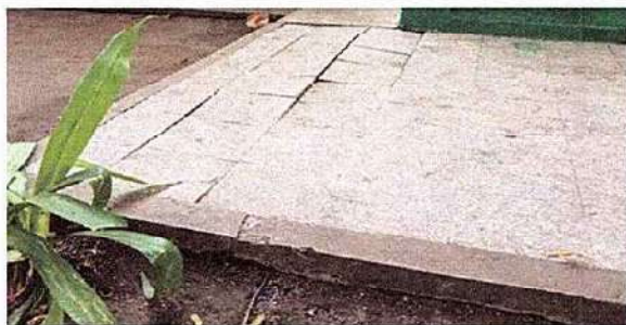
Foto 5: 6.1 Reparación de pisos de torta de concreto.
