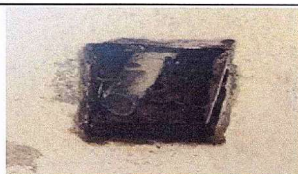
FOTO 16. 18.5 Sustitución de tomacorrientes dobles
