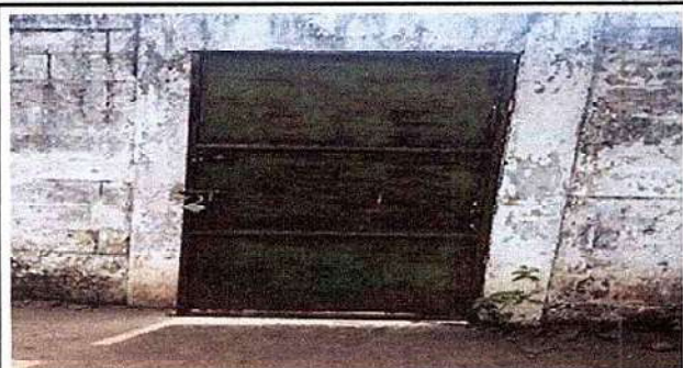
Foto 1: 4.1 Mantenimiento de estructura (lijar, cambio de tubo, sepillado, sujeción, aplicación de pintura)
