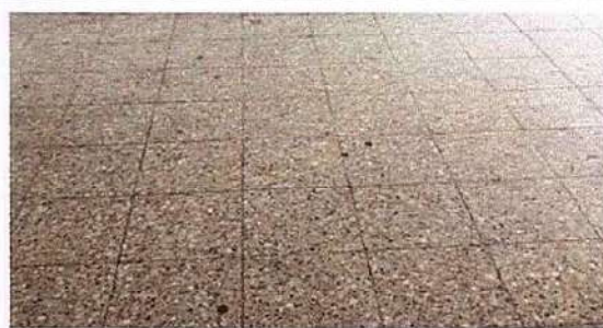
Foto 6: Reparación de pisos de torta de concreto.
