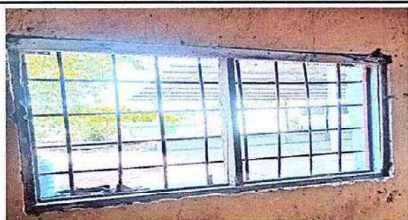
Foto 3: 5.7 Sustitución de estructura de metal de ventana
