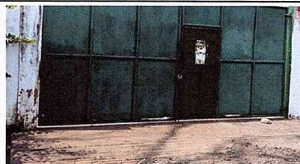
Foto 12: 12.1. Mantenimiento a porton de metal
