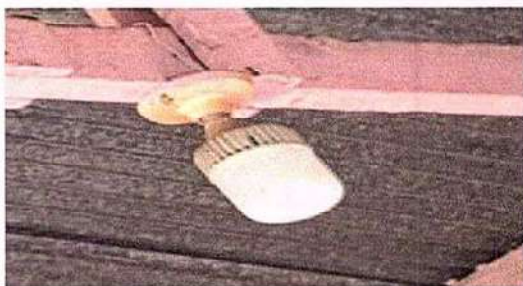
Foto 3: 17.4 Sustitución de focos ahorradores 17.5 Sustitución de plafoneras
