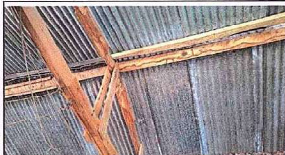
Foto 1: 1.1 Sustitución de lámina, por lámina troquelada aluzinc calibre 26 1.2 Sustitución de capote de lámina troquelada, 1.3 Sustitución de elementos de fijación.
