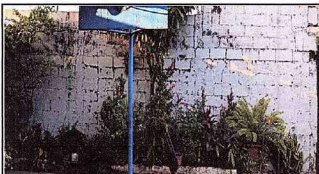
Foto 9: 23.10 REPARACION DE MURO DE BLOCK
