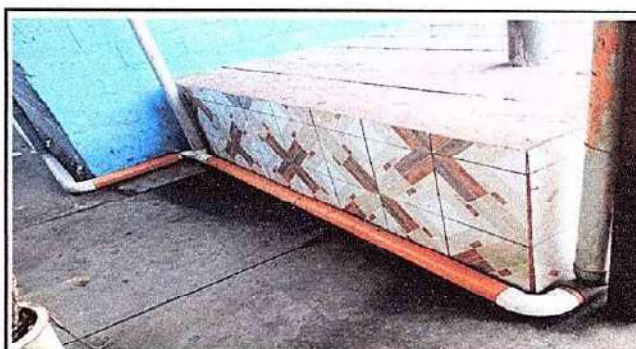
Foto 4: 7.3 REPARACION DE BAJADA DE AGUA PLUVIAL, TUBO PVC 3"
