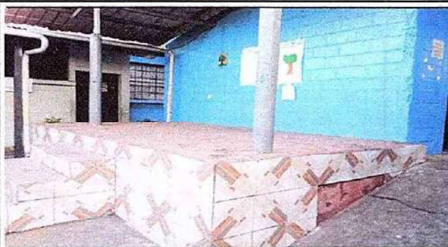
Foto 1: 6.8 SUSTITUCION DE PISO CERAMICO POR PISO CERAMICO
