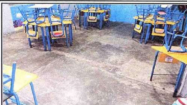
Foto 2: 6.10 SUSTITUCION POR PISO DE CONCRETO POR PISO CERAMICO
