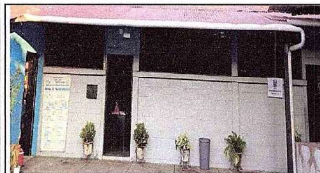
Foto 3: 7.2 SUSTITUCION DE CANAL DE PVC.
