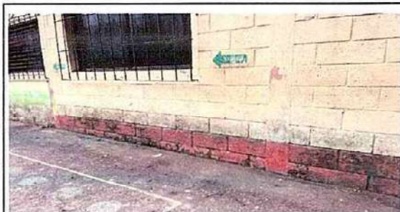
Foto 5. 9.1 Pintura en muros exteriores e interiores
