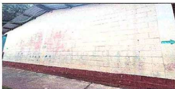
Foto 5. 9.1 PINTURA EN MUROS EXTERIORES E INTERIORES
