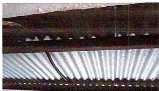
Foto 1.1 Sustitución de lámina, por lámina troquelada aluzin calibre 26. 1.3 Sustitución de elementos de fijación.
