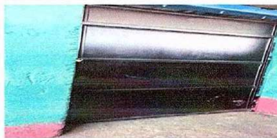
Foto 2. 4. PUERTAS DE METAL 4.2 SUSTITUCIÓN DE CHAPAS
