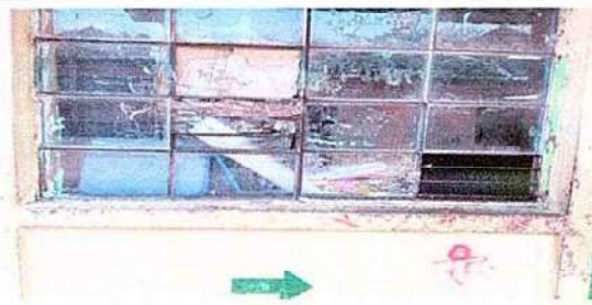
Foto 2: 5.2 SUSTITUCION DE ESTRUCTURA DE METAL POR VENTANA
