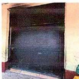
Foto1: 4.2 SUSTITUCION DE CHAPAS
