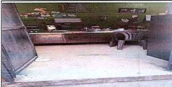
Foto 3: 6..10 SUSTITUCION DE PISO DE CONCRETO POR PISO CERAMICO
