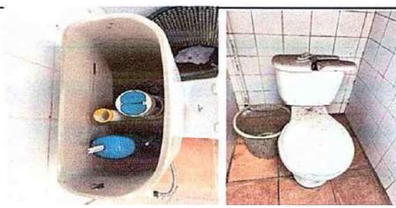
Foto 6. 10.2 SUSTITUCION DE ACCESORIOS INODORO (CONTRA LLAVE, TUBO, DE ABASTO Y TANQUE. 10.3 SUSTITUCION DE INODORO
