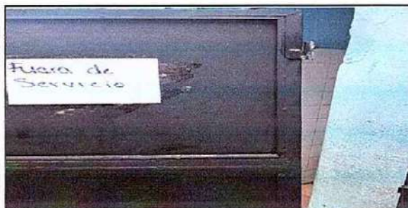
Foto 3. 4. PUERTAS DE METAL 4.4 SUSTITUCION DE PUERTAS EN SERVICIOS SANITARIOS
