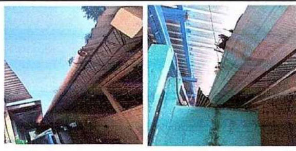
Foto 4: 7.1Sustitucion de canal de metal , 7.4 sustitucion de bajada de agua pluvial de metal por tubo pvc 3
