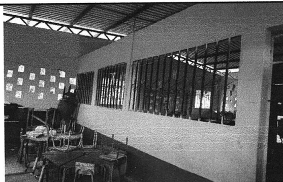
Foto 6: 23.1 Reparación de muro de block (Reforzamiento de muro y columnas)
