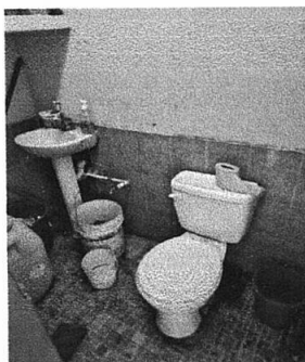
Foto 3: 10.3 Desinstalación e instalación de 2 sanitarios
