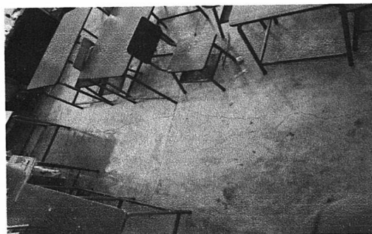
Foto 2: 6.11 Sustitución de piso de cemento liquido por piso cerámico
