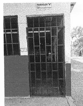
Foto 4: 11.2 Sustitución de 3 barandas de metal, fabricación e instalación de barandas
