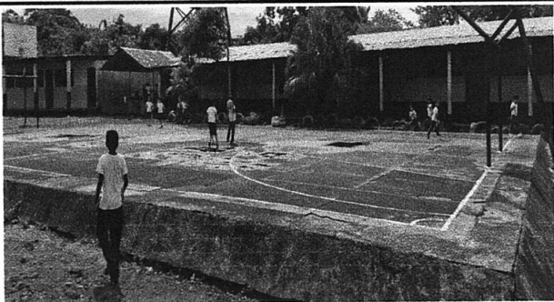
Foto 5: 23.1 Reparación plancha de concreto (Cancha)
