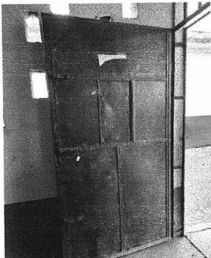
Foto 1: 4.3 Sustitución de 3 puertas, fabricación e instalacion de puertas
