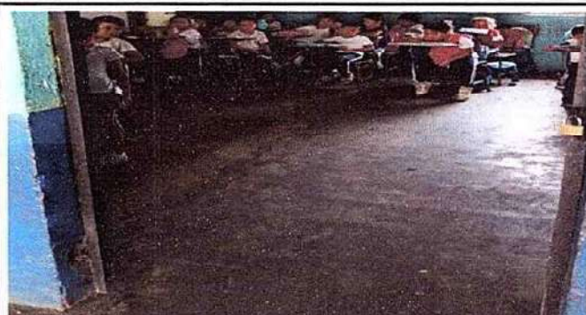
Foto 2: Foto 1: 6.10 Sustitución de Piso torta de cemento por piso cerámico, grados de Kinder y de Dirección
