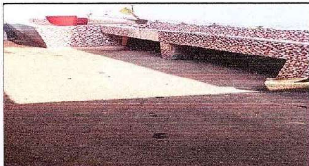
Foto 4: 6.10 Sustitucion de piso de concreto por piso cerámico en el area de baños de niñas.
