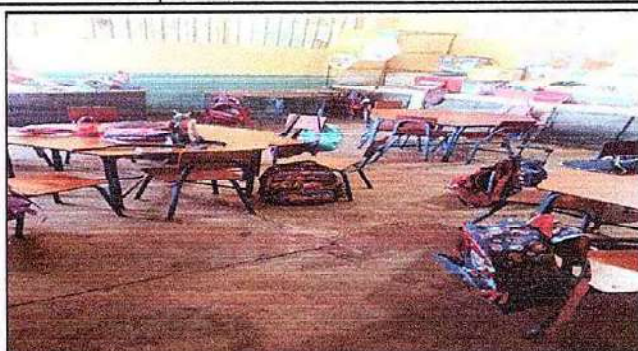
Foto 2: 6.10 Sustitucion de piso de concreto por piso cerámico 8,9
