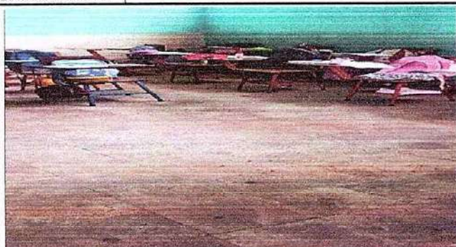
Foto 1: 6.10 Sustitucion de piso de concreto por piso cerámico en el aula 1,2,3,4,5,6,7
