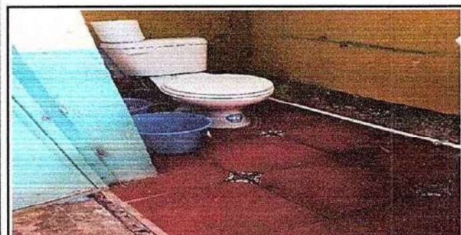
Foto 5: 13.1 Sustitución de Azulejo baños de preprimaria
