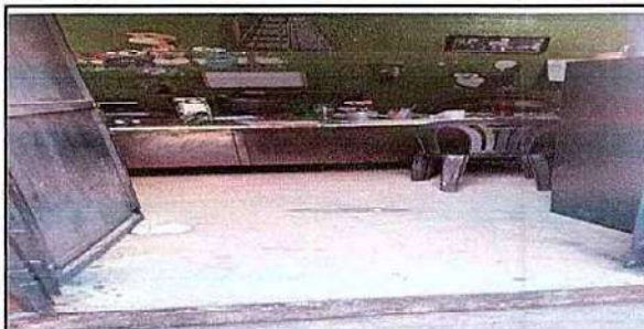
Foto 3: 6..10 SUSTITUCION DE PISO DE CONCRETO POR PISO CERAMICO
