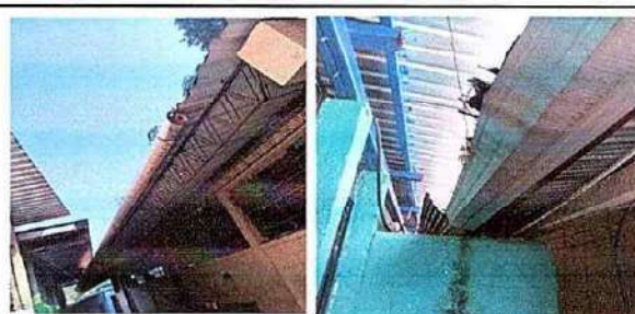
Foto 4: 7.1Sustitución de canal de metal , 7.4 sustitucion de bajada de agua pluvial de metal por tubo pvc 3
