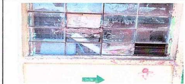
Foto 2: 5.2 SUSTITUCION DE ESTRUCTURA DE METAL POR VENTANA
