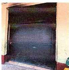
Foto1: 4.2 SUSTITUCION DE CHAPAS
