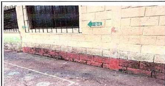
Foto 5. 9.1 Pintura en muros exteriores e interiores
