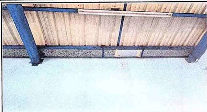
1.1 Sustitución de lamina troquelada aluzin calibre 26 Sustitucion de lementos de fijación. troquelada.
