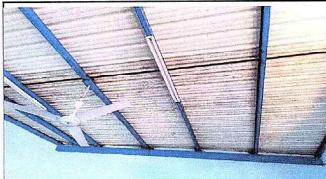
2. ESTRUCTURA DE TECHO 2.1 MANTENIMIENTO DE ESTRUCTURA
