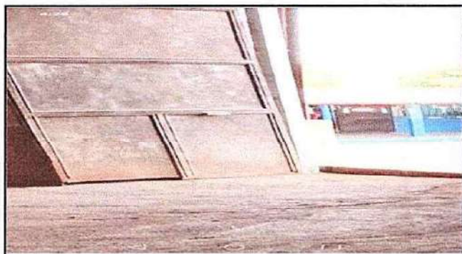
Foto 3: 4.3 Sustitucion de puerta
