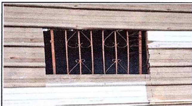
Foto 4: 5.6 Sustitucion de balcones de metal
