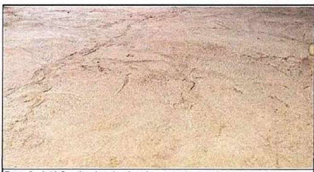
Foto 5: 6.10 Sustitucion de piso de concreto por piso ceramico
