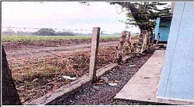
Foto1: 15.6 Mejoramiento a muro perimetral con 3 hiladas de block mas malla y tubo galvanizado
