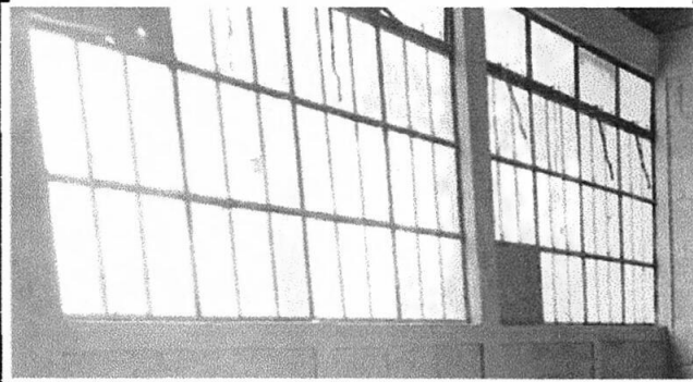
Foto1: 5 5.8 Sustitución de ventanas de metal por ventana de PVC
