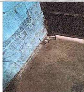
6.6 Sustitución de piso torta de concreto
