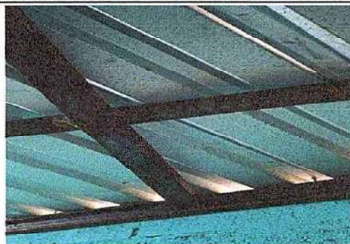
1.3 Sustitución de elementos de fijación
