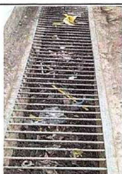
8.1 Reparación de cunetas de concreto
