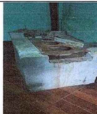
20.2 Sustitución de estufa rural (completa) incluye chimenea y plancha de metal
