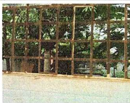
5.6 Sustitución de balcones de metal
