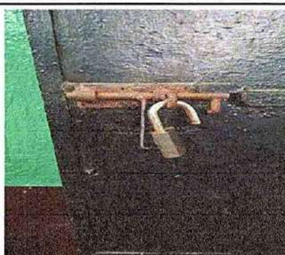
4.2 Sustitución de chapa
