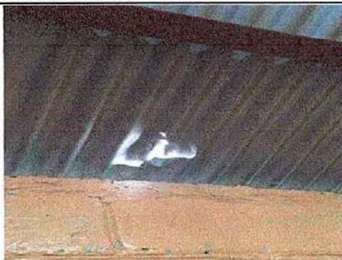
1.1 Sustitución de lámina, por lámina troquelada aluzink calibre 26
