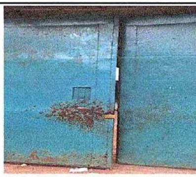
4.5 Sustitución de porton de metal
