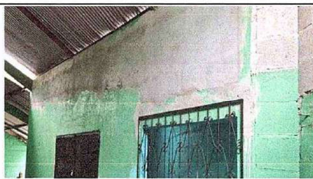
9.1 Pintura en muros exteriores e interiores
