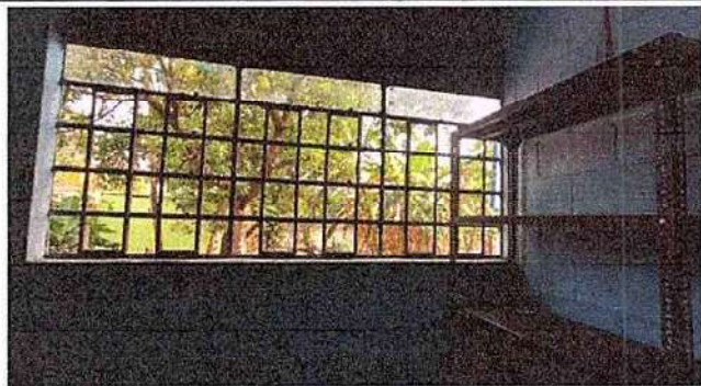
5.3 Sustitución de ventanas de madera por metal mas vidrio
