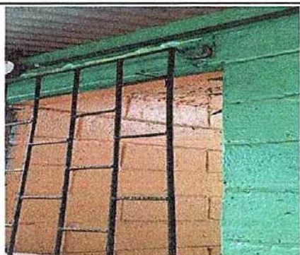
5.7 Mantenimiento de balcones de metal
