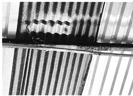
4: 2.3 sustitución de estructura de soporte de metal, por metal
