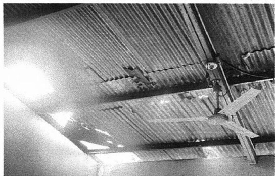
1: 1.1 sustitución de lámina por lámina troquelada aluzinc
