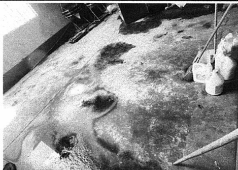
5: 6.10 sustitución de piso de concreto por piso cerámico
